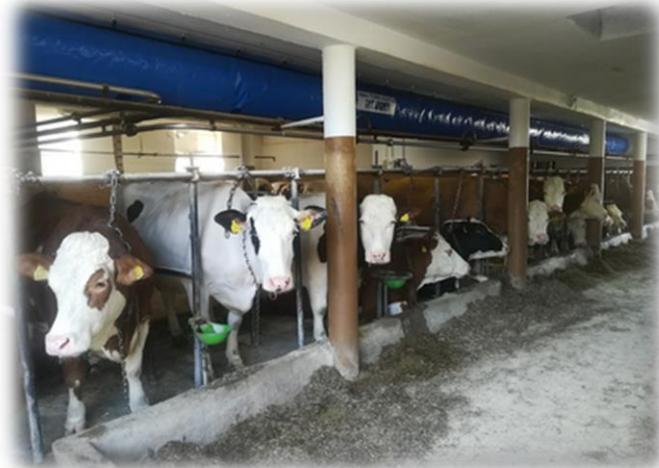
**Ventilatore + tubo di distribuzione dell'aria con innovativo sistema di fori per l'uscita dell'aria**
