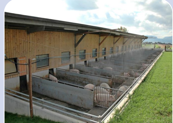
Accesso parziale outdoor
