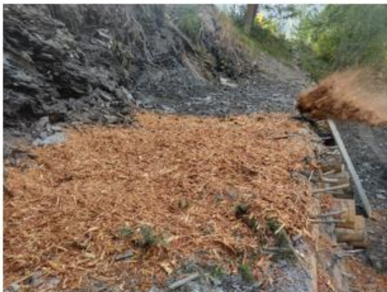
Prove di impiego di corteccia per pacciamatura scarpate recuperate e consolidate
