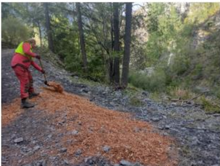
Prove di impiego di corteccia per pacciamatura scarpate recuperate e consolidate
