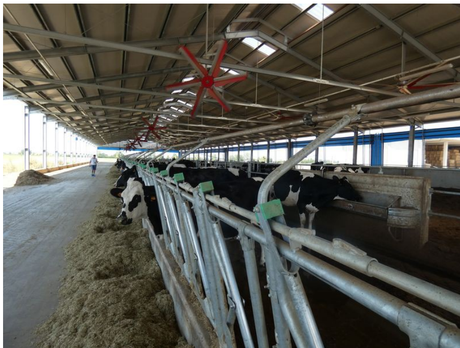
Figura 3.14 – Impianto di raffrescamento estivo della stalla n.1 dell'azienda H: al centro ventilatori Vertigo a canale di vento, a destra ventilatori tipo elicottero a cascata di vento
