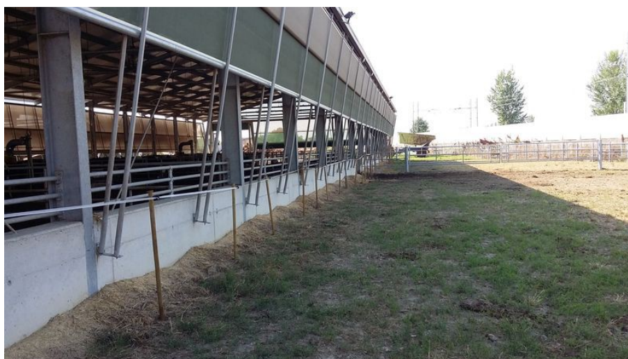
Figura 2.10 – Il paddock esterno in terra della stalla dell'azienda C
